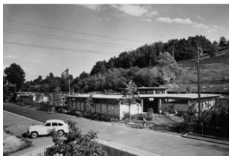
<10_Schwimmbad Im Moos Foto: Michael Wolgensinger, © 2010 Pro Litteris Zürich
