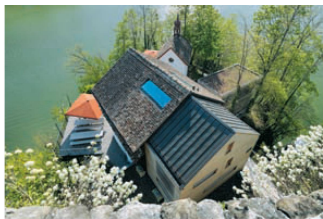
^ Ein Neubau schmiegt sich an den Rücken des alten Gasthauses.
