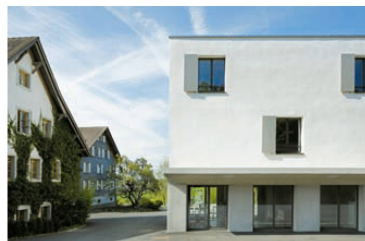
^Trotz klarer Sprache übernimmt die neue Architektur Elemente der alten.
