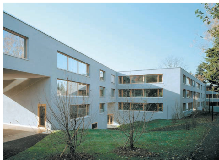
<Mit den Knicken und den doppelgeschossigen Durchgängen passt sich das grosse Haus dem Terrainverlauf an.
