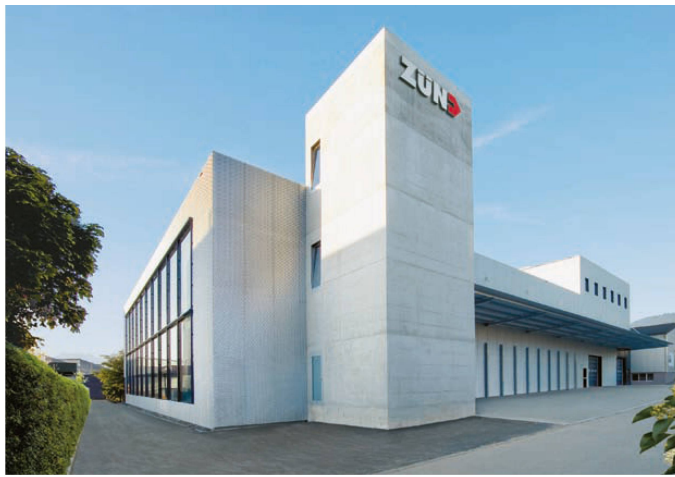
<Der Treppenturm am Industriegebäude in Altstätten kontrastiert zur Fassade aus Aluminium.
