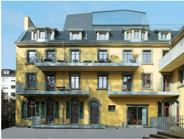
<Sichtbare Eingriffe: Neue Balkone und ein Aufbau, der im Dachstock Platz schafft und Licht hineinbringt.
