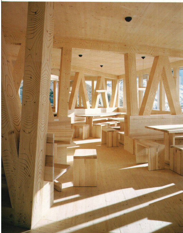
<Das Holz des Elementbaus prägt das Innere der neuen Monte Rosa-Hütte.
