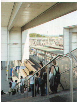
<6 S-Bahn-Station Wankdorf: Bereits hat sich die neue Station als Verkehrsknoten etabliert.
