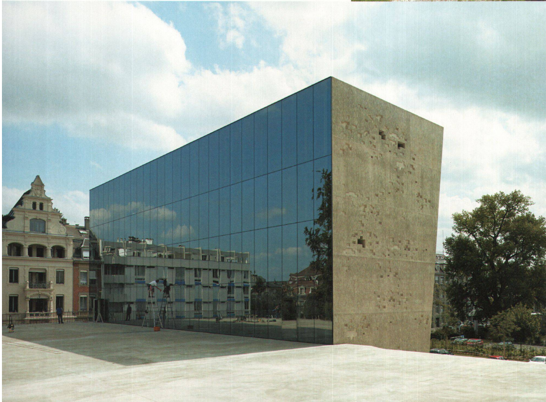
<3 Historisches Museum: Das Dach des grossen Ausstellungssaals ist ein Platz, der dem ganzen Museum dient. Hinter der Glasfassade liegen auf vier Geschossen die Büros.
