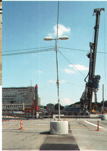
>4 Wankdorfplatz: Bis 2012 ist der Platz noch eine Grossbaustelle.
