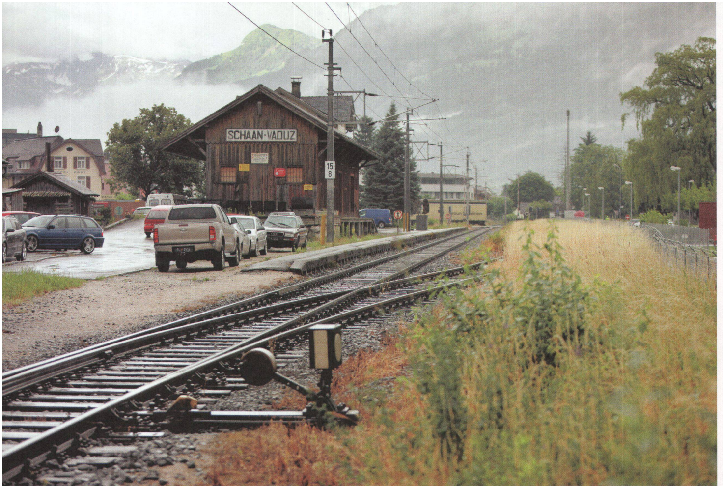
^Eingleisig fährt die Eisenbahn durchs Fürstentum Liechtenstein von Buchs nach Feldkirch.
