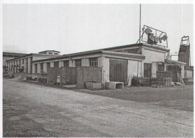
< Die Firma Favre & Co. produzierte bis 1989 auf dem Areal Betonröhren.
