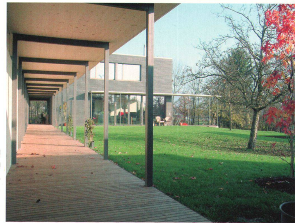
> Der gedeckte Gang bietet einen schönen Zugang zum Haus.
