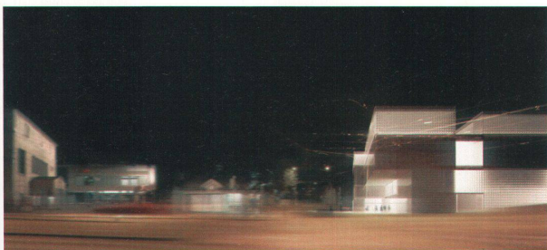
✓ 2. Rang von Gigon/Guyer mit Fassaden aus Glasbausteinen.
