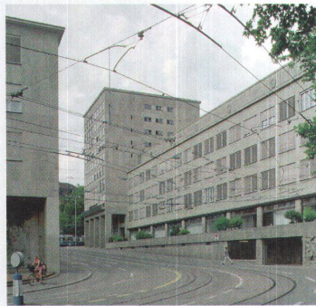
2 Verwaltungsgebäude Walche, Zürich
