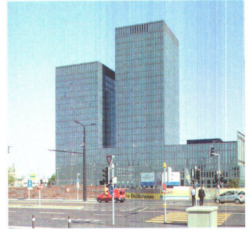
10 Hochhäuser Hagenholzstr., Zürich
