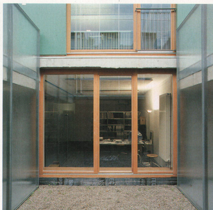
Die Lichthöfe auf der Strassenseite belichten die Ateliers im Untergeschoss
