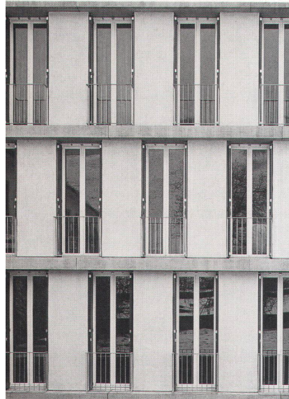
Die fortlaufenden Reihen der tragenden Wandplatten sind von Geschoss zu Geschoss gegeneinander versetzt
