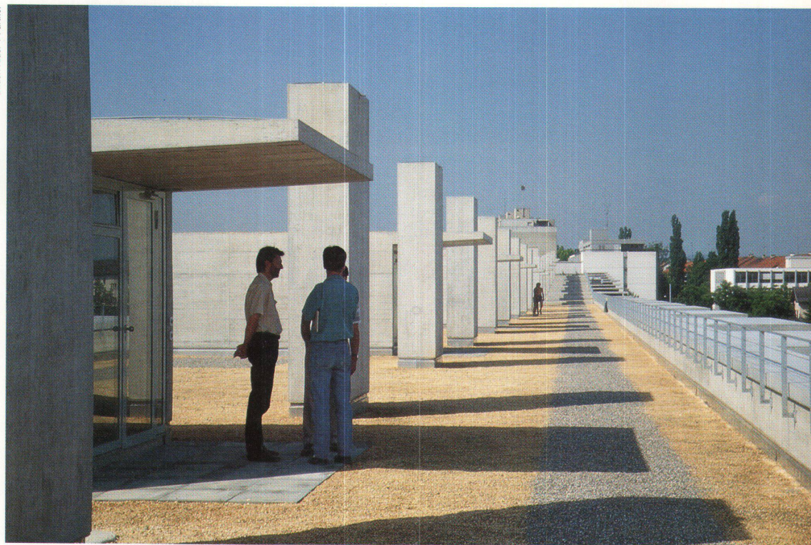
Die «Promenade urbaine» auf dem Dach: ein Spazierweg mit Stadtaussicht
