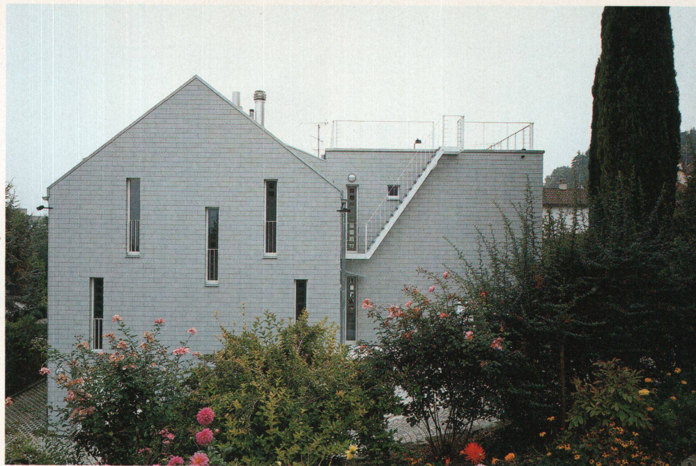
Ostfassade mit der Schiffstreppe zum Dachgarten. Die Fenster sitzen im Altbau an der alten Stelle, sind aber zum Hochformat umgestaltet worden.
