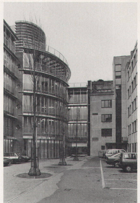
Hofansicht mit dem Rundbau und dem Anschluss an das Nachbargebäude. Das Absetzen mit einer Kerbe wird deutlich.
