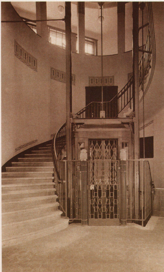
Im Liftschacht befinden sich heute verschieden nutzbare Etagen.
