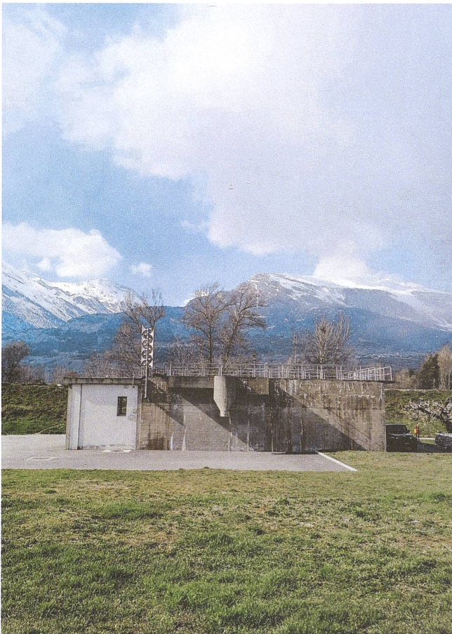
Vor der Umnutzung: das Becken der Kläranlage, das jahrzehntelang leer stand
