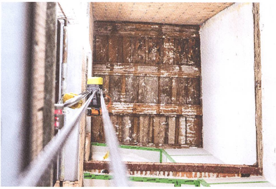
Blick durch den eingeschnittenen Schacht auf die alten Decken.
