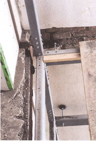
Stahlgerüst und Abstandspuffer.
