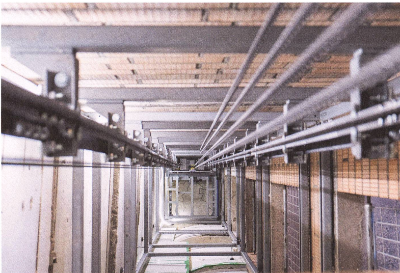
Das eingepasste Stahlgerüst geht über alle Stockwerke.
