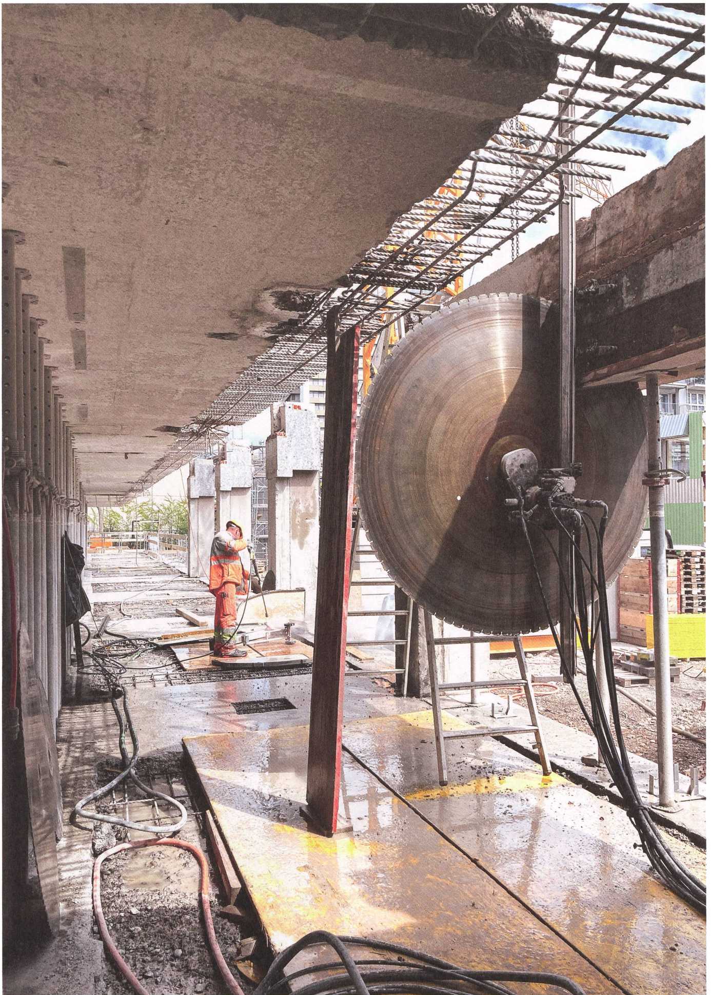
Für die Umnutzung wurde die Struktur des ehemaligen Weinlagers in Basel auf beiden Seiten um rund einen Meter zurückgeschnitten. Foto: Esch Sintzel
