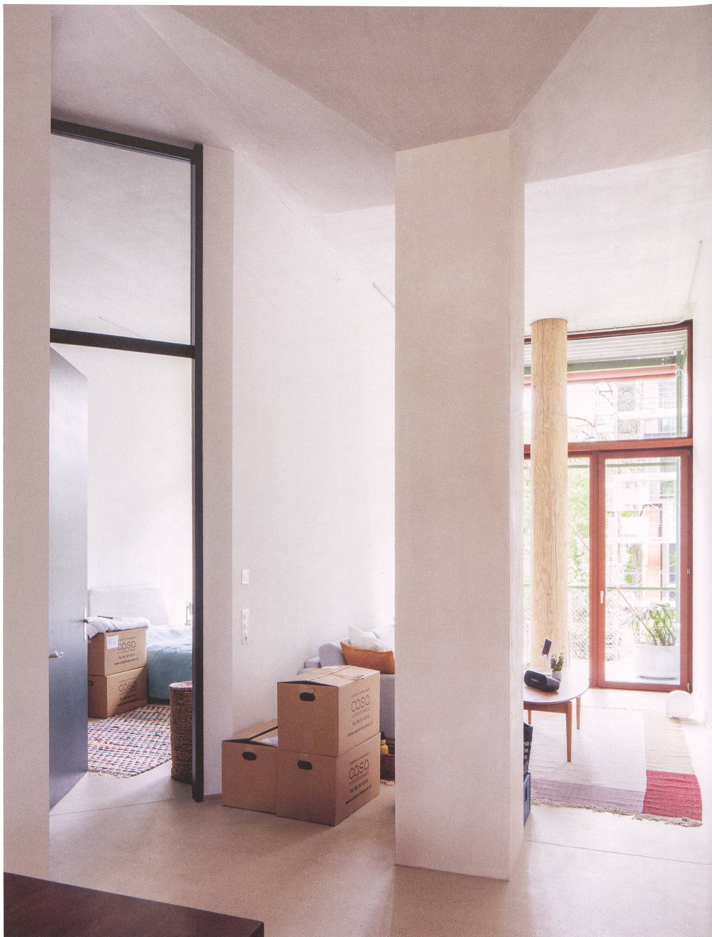
Neue Rundholzstützen ergänzen die mächtigen Betonstützen, die aus dem Bestand stammen und mitten im Wohnraum stehen. Foto: Paola Corsini
