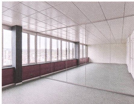
Die Architekten ersetzten die Fenster; die neuen unterscheiden sich dank schlanken Profilen nur wenig.
