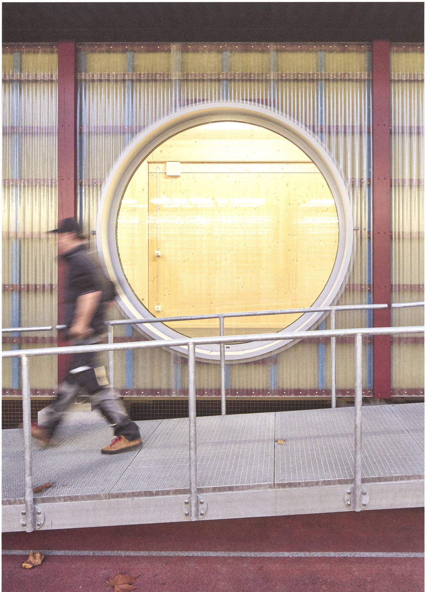
Die Fassade aus Kunstharzplatten und Holz lässt sich an den Kontext anpassen.
