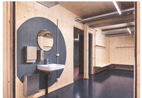
Bäder und Duschen sind als Module aufgebaut.
