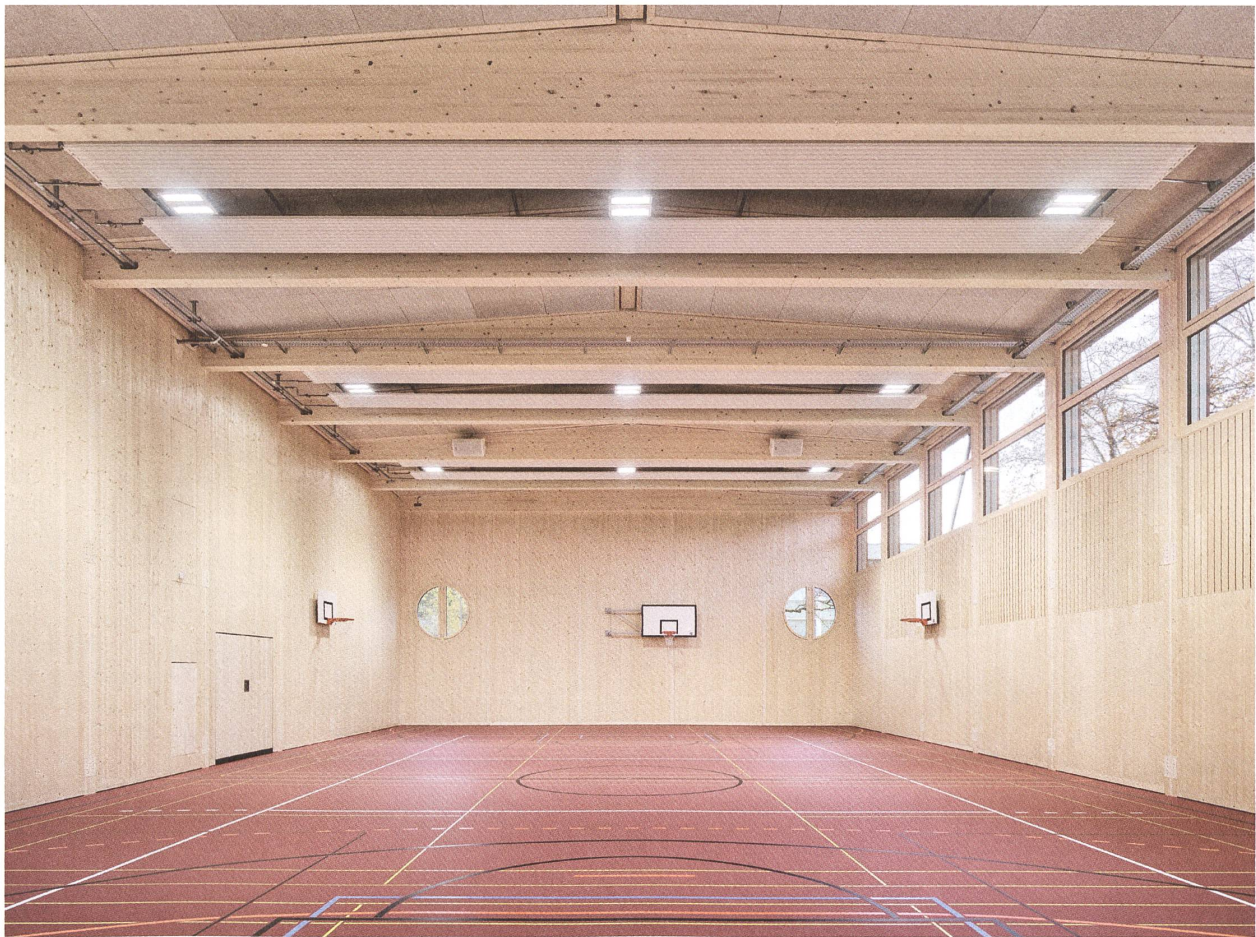
Die Tragstruktur basiert auf Elementen, die in der Turnhalle sichtbar miteinander verbunden sind.
