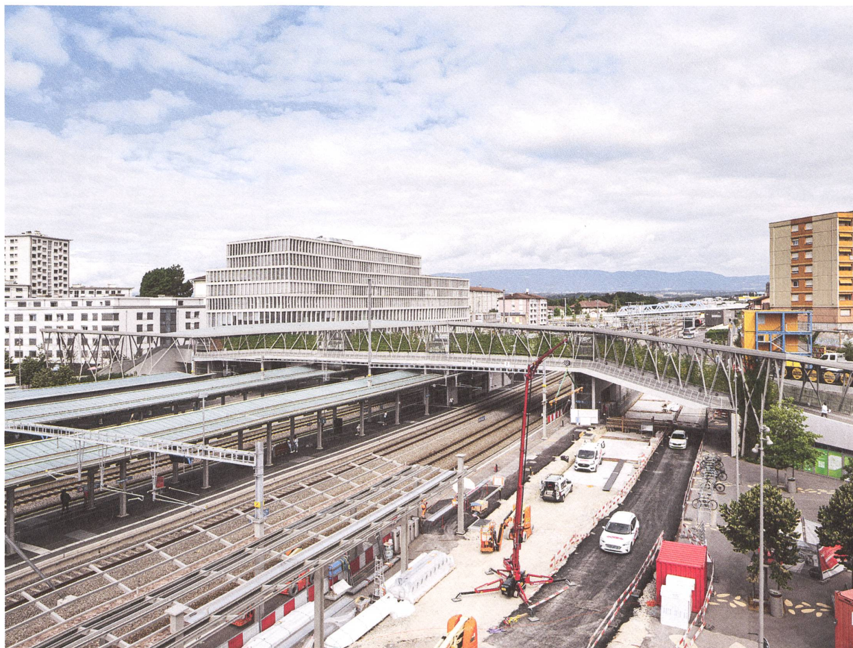
Blick über den Bahnhof und die Baustelle für die 2026 in Betrieb gehende Tramhaltestelle. | Vue sur la gare avec, au premier plan, le chantier de l'arrêt de tram qui entrera en fonction en 2026.
