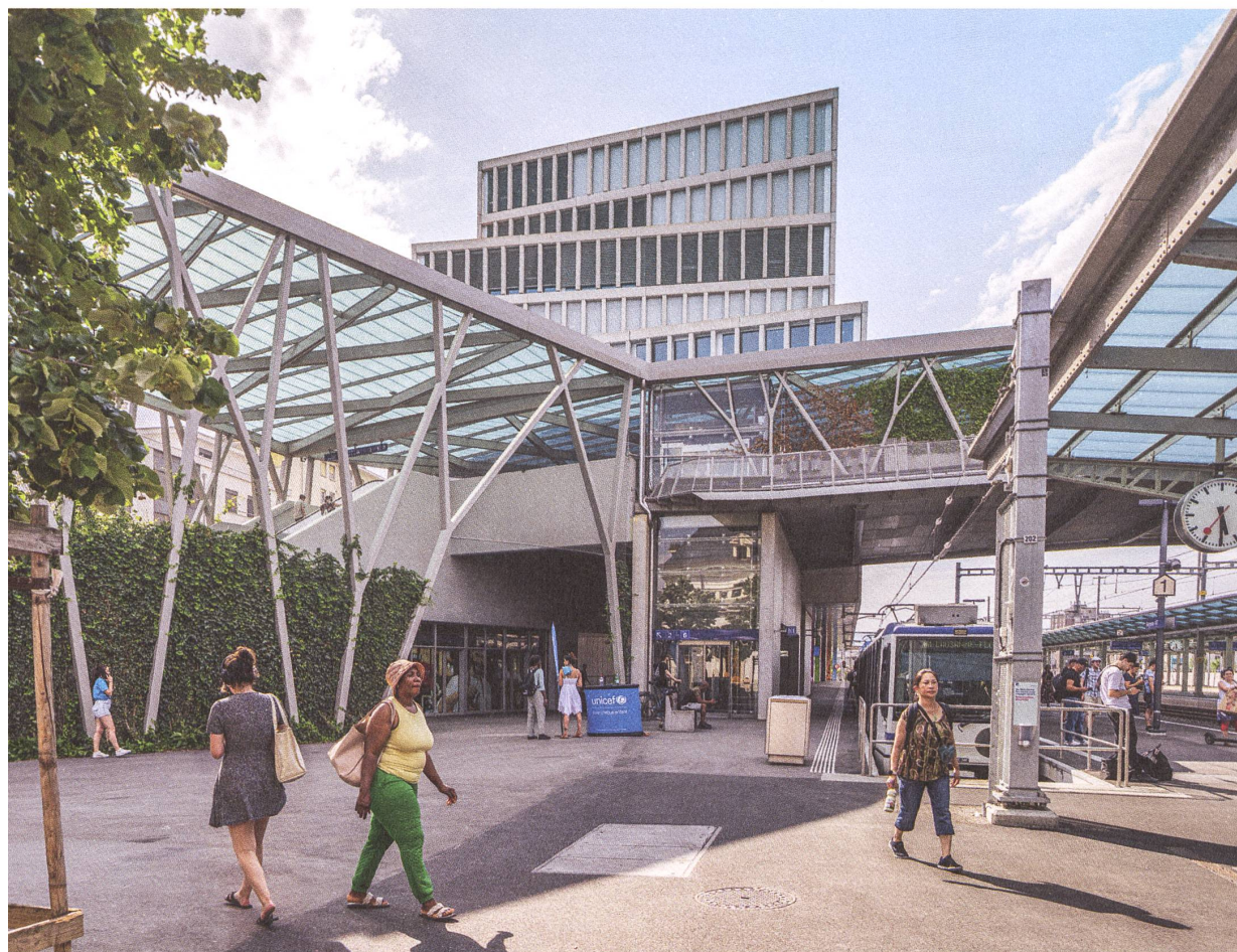
Metrostation und Liftaufgang zur Passerelle. | Station de métro et ascenseur vers la passerelle.
