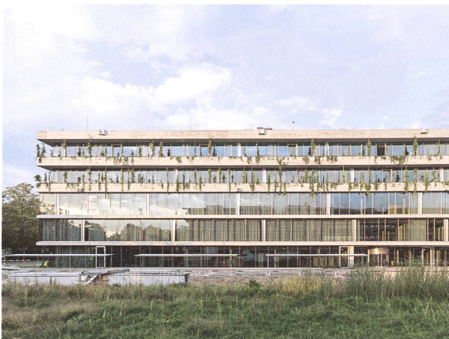
Über zwei Laborgeschossen befinden sich die zwei Büroetagen mit bepflanzter Loggia. Fotos: Mark Niedermann
