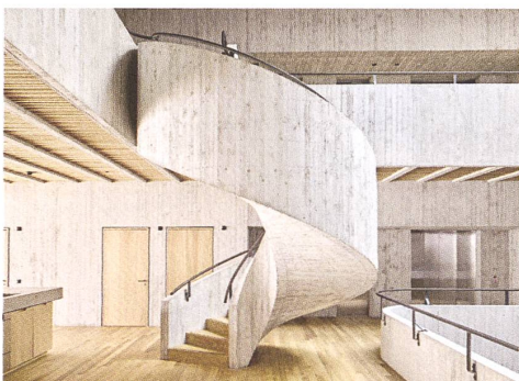
Im Foyer verbinden plastisch geformte Wendeltreppen aus Beton die Büros mit den Laboren.
