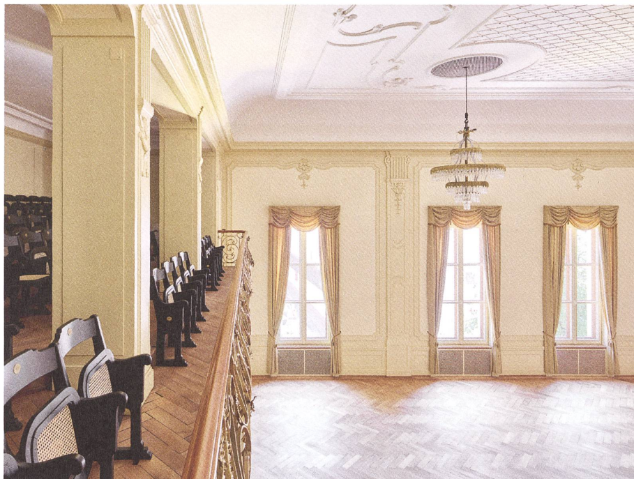
Auch der kleine Saal des Basler Stadtcasinos wird neu belüftet. Die Abluftöffnungen integrieren sich nahtlos in den Deckenstuck über den Lüstern. Fotos: Roman Weyeneth
