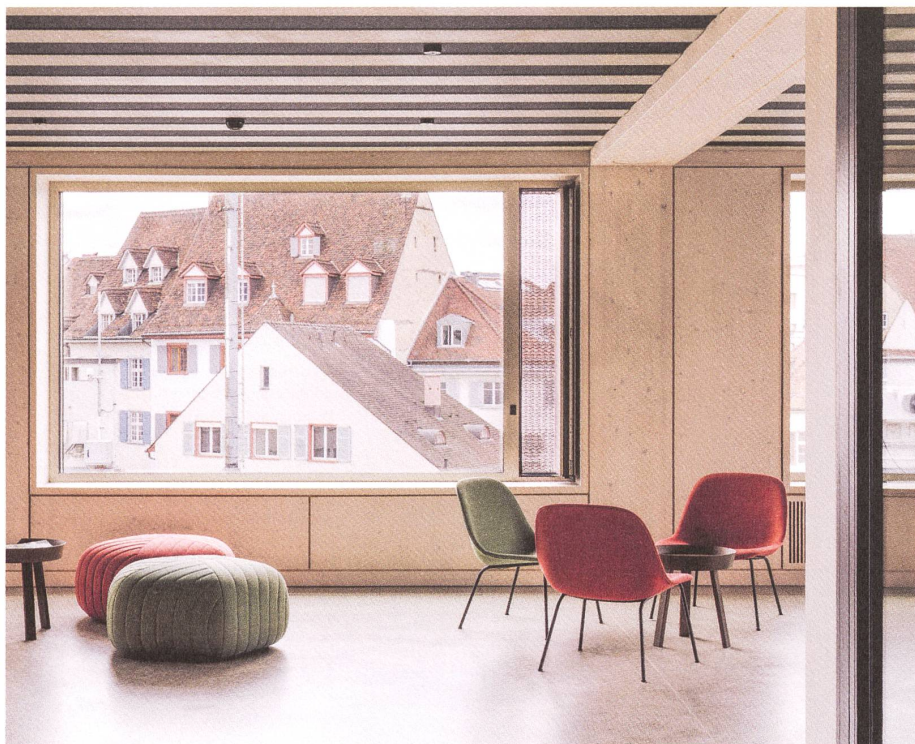
Die Hybriddecken aus Beton und Holz prägen die Räume. Fotos: Daisuke Hirabayashi
