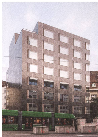
Die Photovoltaik-Fassade vereint Funktion und Schmuck.
