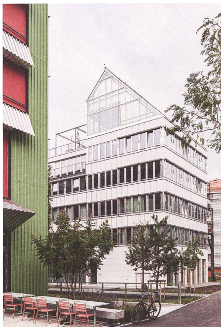
Ein Gewächshaus sitzt auf dem Neubau in Basel.
