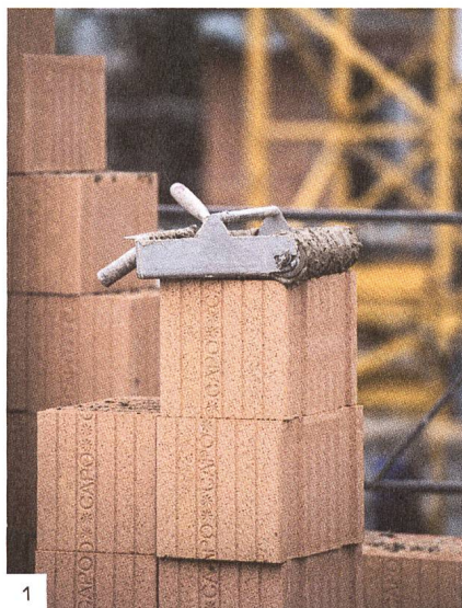
1 Der Wärmedämmstein «Capo» vereint beim Einsteinmauerwerk alle Trag-, Dämm- und Schutzfunktionen. Fotos: Gasser Ceramic
