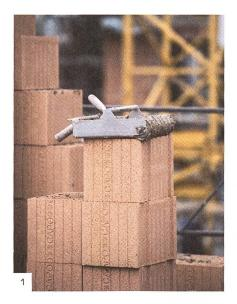
Der Wärmedämmstein (Capo) vereint beim Einsteinmauerwerk alle Trag-, Dämm- und Schutzfunktionen. Fotos: Gasser Ceramic
