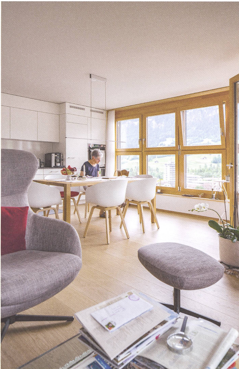
Je nach dahinterliegenden Räumen halbieren, dritteln oder vierteln die Querriegel die Fichtenholzfenster. An der Fassade entsteht dadurch eine elegante Unregelmässigkeit.
