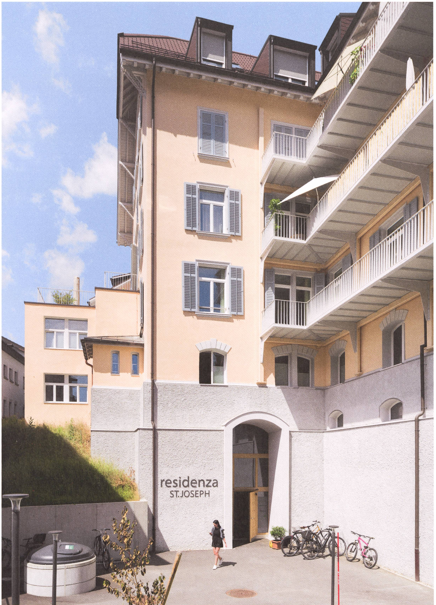
Der Haupteingang liegt im Sockel des sanierten und mit Balkonen erweiterten alten Klosters. Über einen Lift und eine Passerelle gelangt man in den weiter oben gelegenen Wohnturm.
