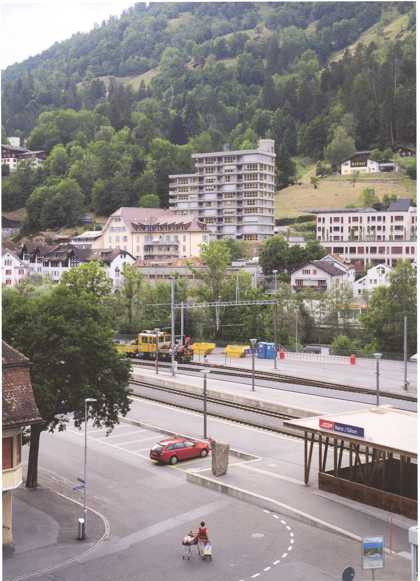
Blick vom Bahnhof Ilanz auf den elfstöckigen Wohnturm der Residenza St. Joseph, der hinter dem alten Kloster und neben dem Spital liegt.
