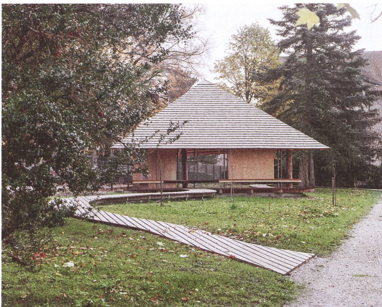
Drei alte Lärchen haben die Dreiecksform des «Umbrella Pavilion» vorgegeben und einen Grossteil des Konstruktionsholzes geliefert. Foto: Joël Tettamanti
