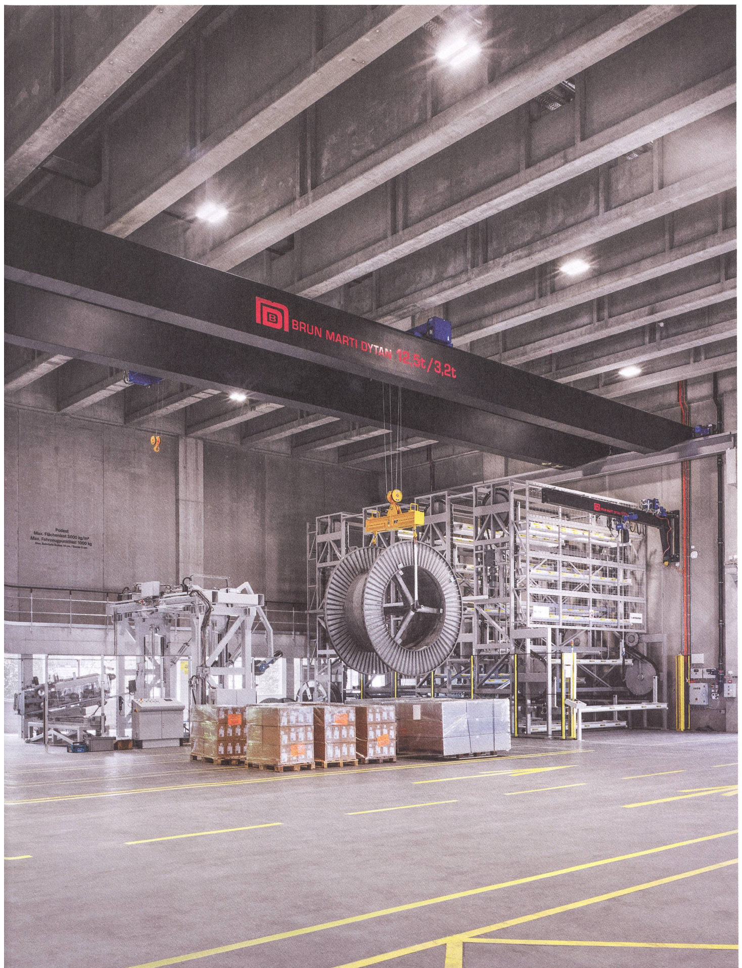
Die eng stehenden Deckenbalken erstrecken sich über 32 Meter Länge und sind 2,3 Meter hoch. Foto: Peter Tillessen
