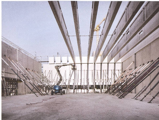
Montage der 2,3 Meter hohen Deckenträger. Darüber wird ein weiteres Geschoss folgen.
