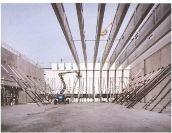
Montage der 2,3 Meter hohen Deckenträger. Darüber wird ein weiteres Geschoss folgen.
