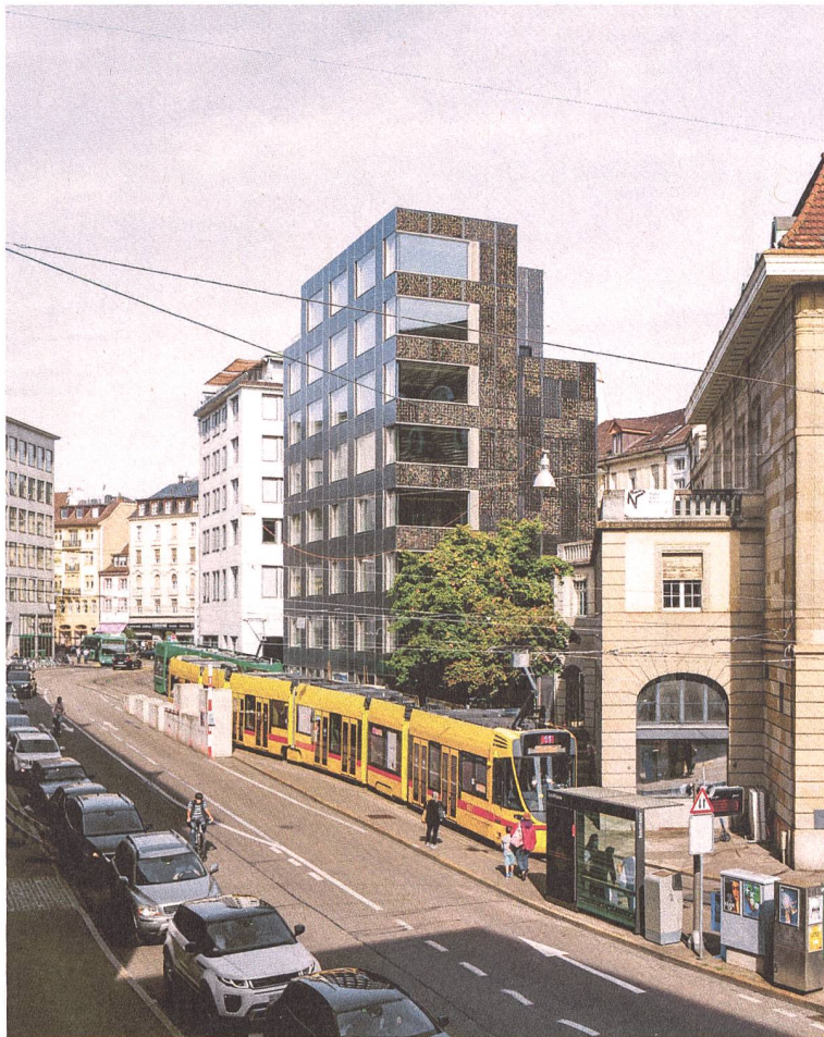
Der Neubau des Amtes für Umwelt und Energie (AUE) mit seiner schmucken Solarfassade steht mitten in Basel. Foto: Daisuke Hirabayashi
