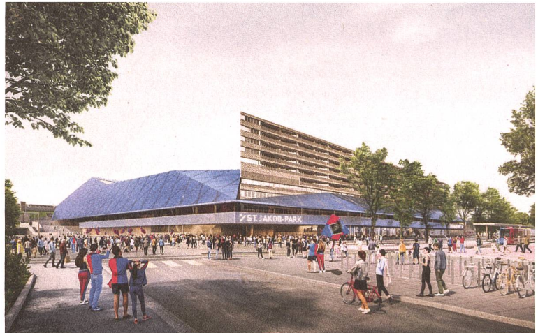
In den kommenden Jahren soll das St. Jakob-Stadion mit einem Solarkraftwerk umhüllt werden. Visualisierung: Herzog & de Meuron
