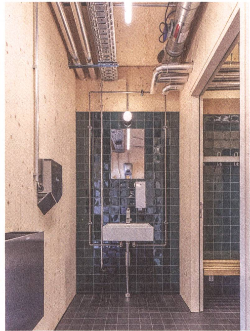
Die Rohre verlaufen sichtbar auf der Wand.
