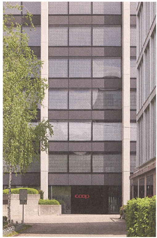
Den Brüstungsbändern sieht man nicht an, dass sie Strom produzieren.
