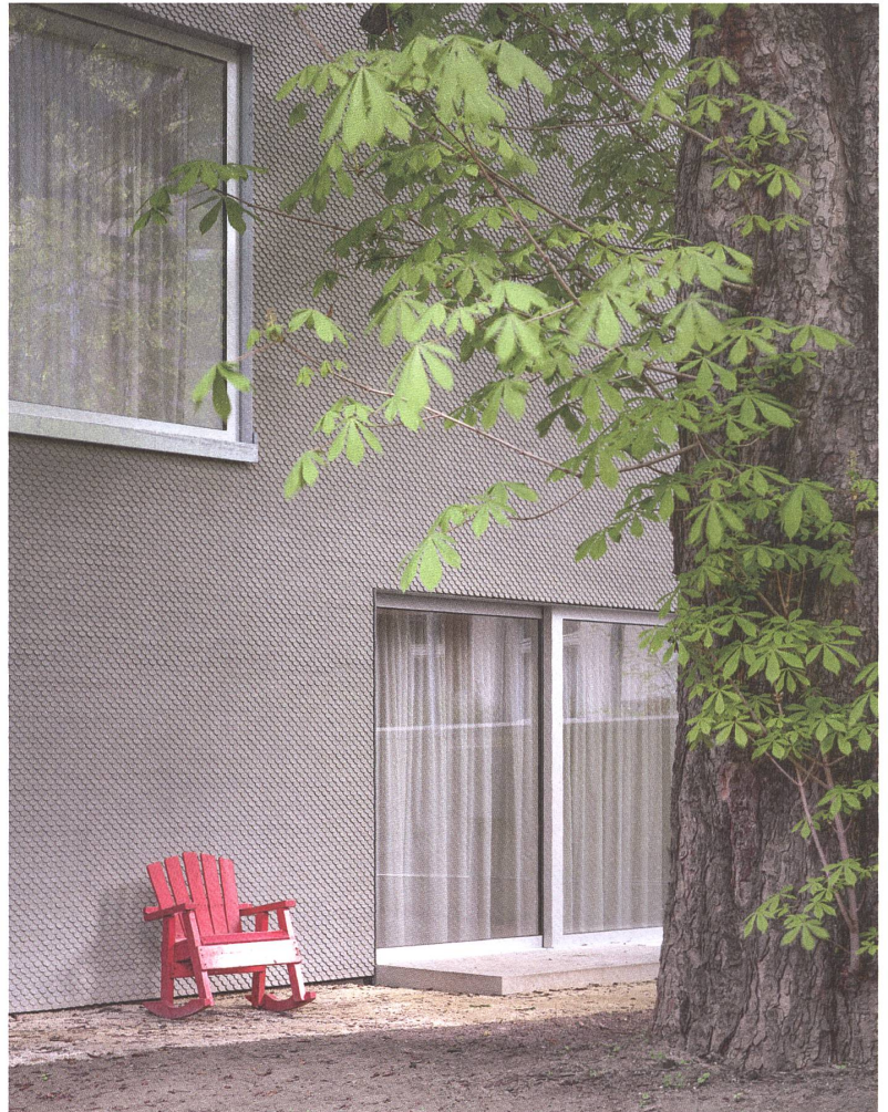
Von Nahem erkennt man nicht nur die Rundschindeln, sondern auch die Textur des Faserzements.
