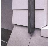
Lisenen und Platten sind unabhängig verbaut und können unterschiedlich altern.
