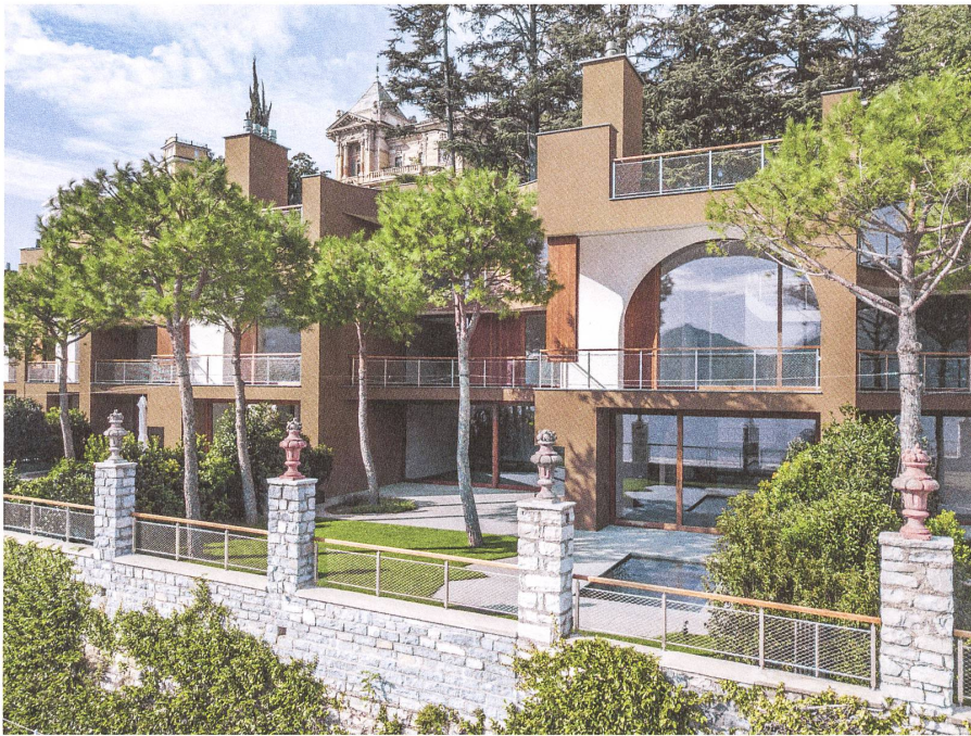
Acht Villen, 2017 Lugano TI Bauherrschaft: Privat Architektur: Herzog & de Meuron, Basel Besonderheiten Fenster: Hebeschiebetüren bis zu 1500 kg, Holzfenster aus Teakholz ohne sichtbare Glasleiste, aufwendiger Transport und Einbau
