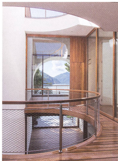
Bis zu 1500 Kilogramm schwer sind die eingebauten Hebeschiebetüren.
