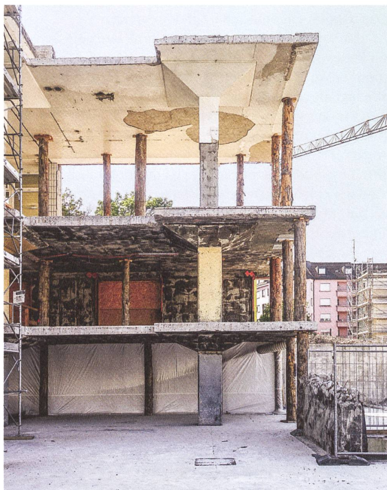
Die Geschosse wurden durch Holzstützen temporär abgestützt.
