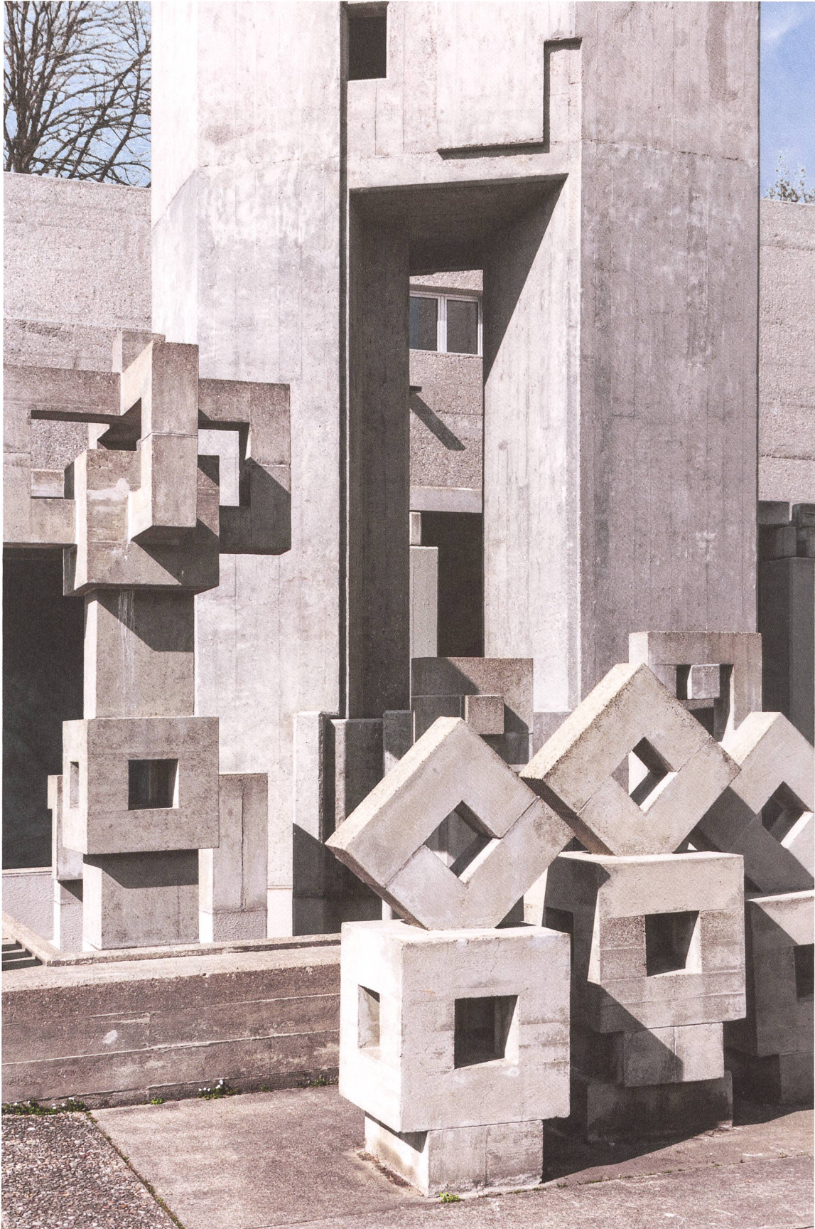
Beim Heizungskamin gestaltete Bildhauer Josef Wyss aus drei Betongrundformen ein Ensemble aus Plastiken, das sich als Kindergruppe lesen lässt.
