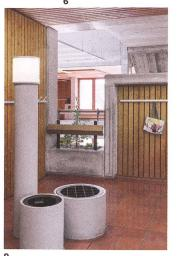
→ Arbeiten. Bereits vor 55 Jahren hatte man eine dünne Dämmschicht auf die Betonwände aufgebracht und mit Holztäfer oder -schränken verkleidet. Diese Einbauten liessen sich entfernen und nach Aufbringen der Dämmung wieder einbauen.
