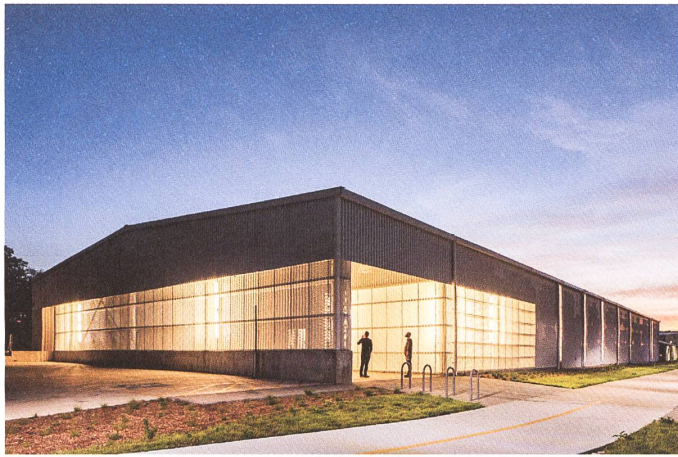
Die «Sculpture Facility» der University of Arkansas
