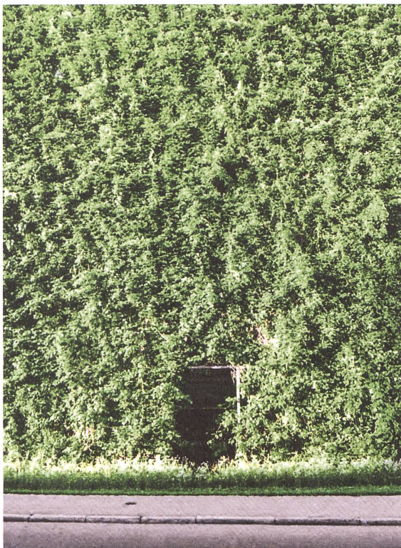
Auch ein Beitrag zur Stadtkühlung: die «Green Wall» in Glattbrugg
