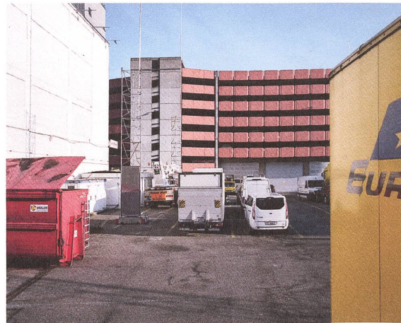
Die Lagerhalle, der Parkplatz und das charakteristische Parkhaus
