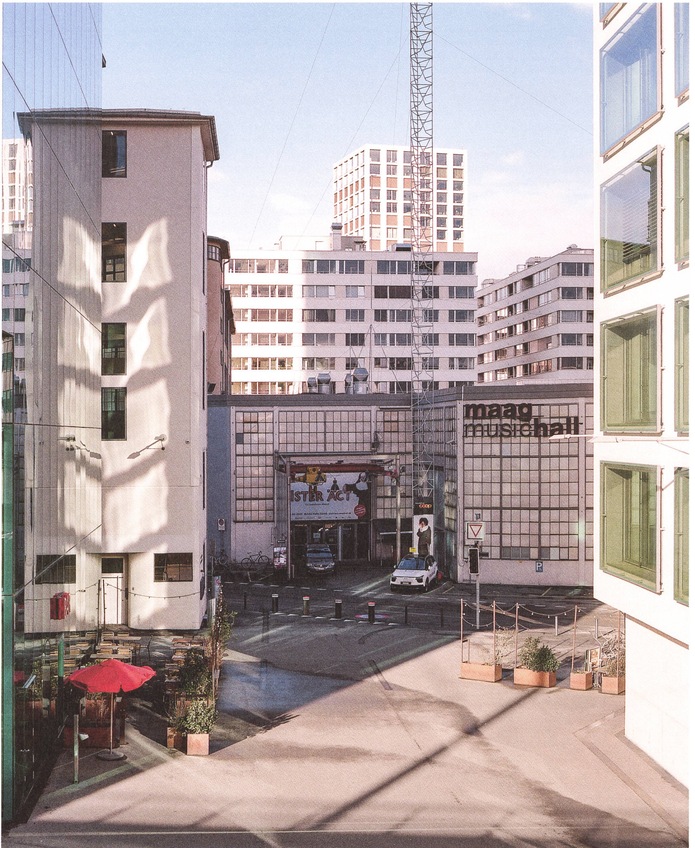
Sinnbild für Zürich West – und ebenfalls vom Abriss bedroht: die Maag-Hallen zwischen Prime Tower und Welti-Furrer-Areal
