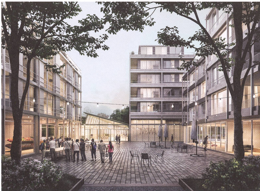
Im südlichen Arealteil umschliessen Wohn- und Gewerbebauten einen städtischen Platz. Visualisierungen: Hosoya Schaefer / Filippo Bolognese
