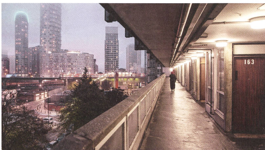
Die Laubengänge der Siedlung «Robin Hood Gardens» gingen als «Streets in the Sky» in die Architekturgeschichte ein.
