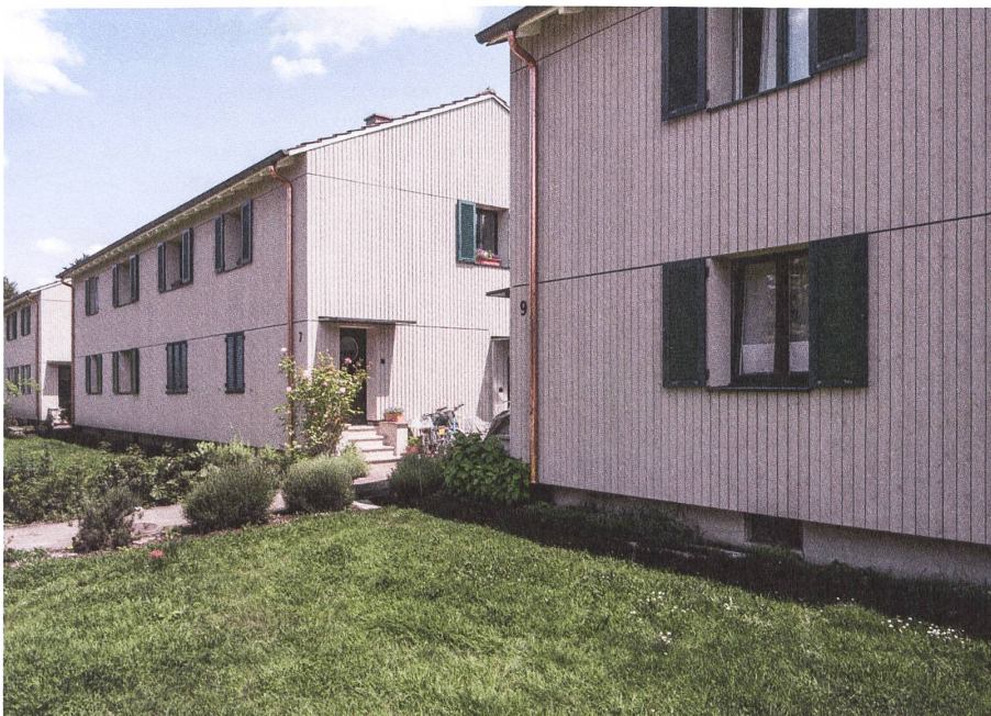
Die Sanierung hat das Erscheinungsbild zur Strasse nur geringfügig verändert.
