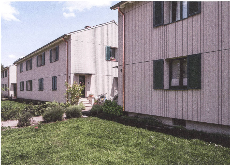
Die Sanierung hat das Erscheinungsbild zur Strasse nur geringfügig verändert.
