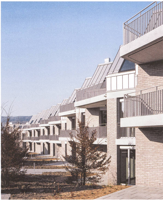
Die gestaffelten Mehrfamilienhäuser nehmen den Verlauf der Hohlen Gasse in Uster auf.
