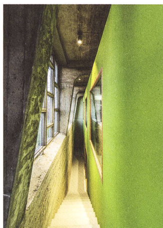
1. Etappe: Holzbox unter Betonkonstruktion im Zwischenbau
