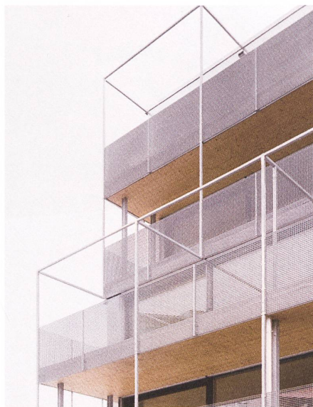
Die Aufstockung ist zum Hinterhof abgetreppt. Die Balkongeländer bestehen aus verzinkten Industriebodengittern.
