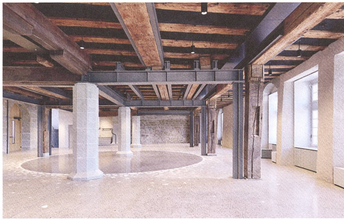
Im offenen Erdgeschoss zeigen sich die statisch notwendigen Eingriffe.
