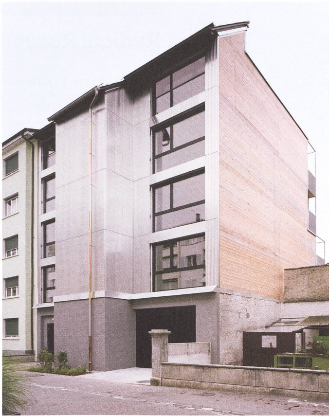
Das Steildach führt die Dachlandschaft des Blockrands weiter. Die Fassade besteht aus rohem Aluminiumblech, das Fallrohr aus Reststücken.
