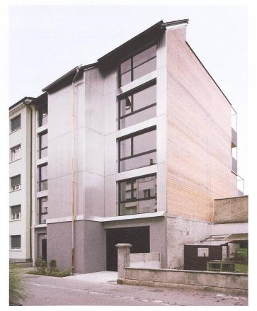
Das Steildach führt die Dachlandschaft des Blockrands weiter. Die Fassade besteht aus rohem Aluminiumblech, das Fallrohr aus Reststücken.
