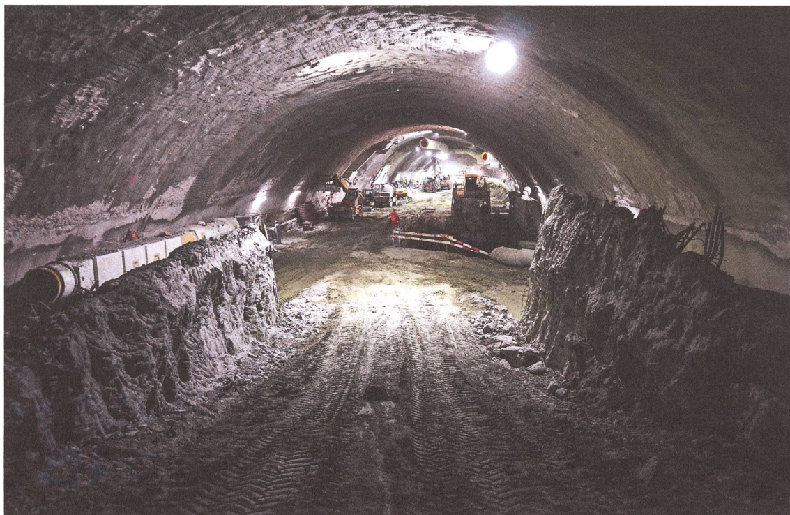
Die Kaverne Nord ist zur Hälfte ausgebrochen. Links und rechts die Reste der Paramentwände zwischen den Sektoren der Ausbruchetappen 2 und 4. Foto: Martin Schäfer
