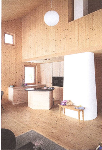
Weitgehend ohne Leim, Metall und Kunststoffe konstruiert: der Hauptraum im Neubau.
