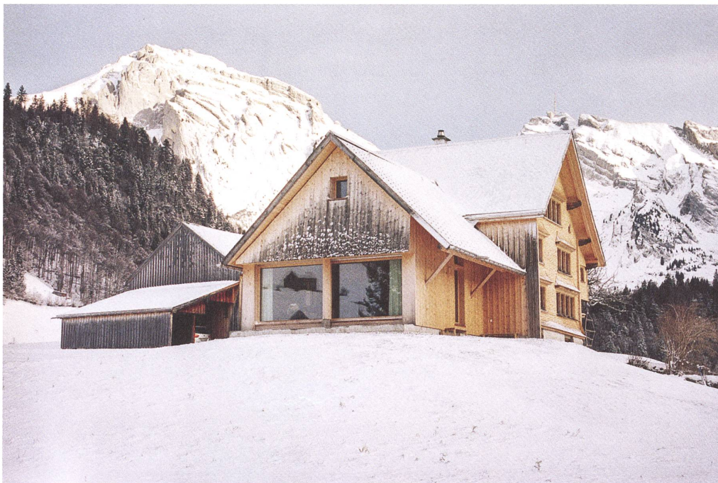
Der Anbau bietet grössere Öffnungen – und doch ist er dem Bauernhaus klar untergeordnet.
