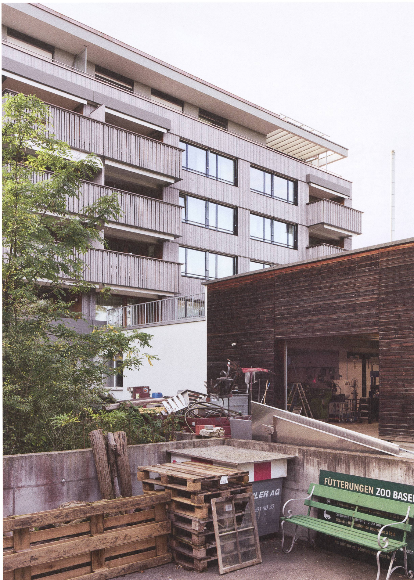
Die sanierte Rückfassade ist neu holzverschalt. Die Balkone haben nun die doppelte Grösse.
