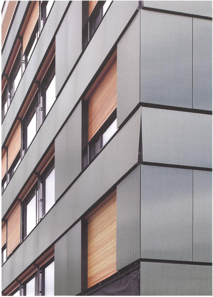
Weil das Standardformat der Solarmodule nicht passend ist, kippt es nun bei den Fensterbrüstungen leicht aus dem Lot.
