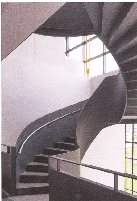
Die gelbe Stütze oberhalb der Wendeltreppe trägt nur im Brandfall.
