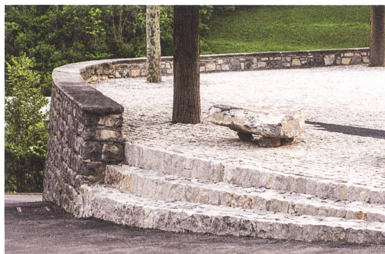
Der neue Bodenbelag ist dank des verfugten Zementmörtels wasserdicht.
