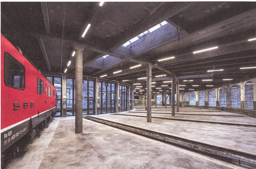
Die im Ursprungszustand erhaltene Stahlbetonstruktur wurde statisch ertüchtigt, die Oberflächen hat man saniert.
